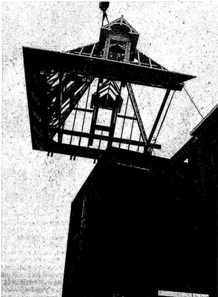
Mise en place de la toiture (le maître d'œuvre supervise l'opération depuis la fenêtre à droite).
